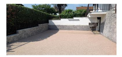
**Descrizione:** Drainfloor è un sistema bicomponente a base di resina epossidica modificata che viene
